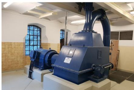
Weiterhin wurden die beiden Düsen der Pelton turbine von einem gemeinsamen Antrieb auf eine individuelle Düsensteuerung umgebaut. Hierdurch wurde der Teillastbetrieb der Anlage optimiert und es wird unter optimaler Ausnutzung der vorgegebenen Abflussmenge der jeweils bestmögliche Wirkungsgrad erzielt.
